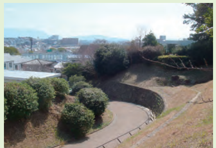
大手口と斜面に残る石垣跡
