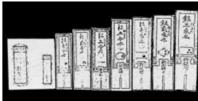
奈多新開堤防工事の手形
