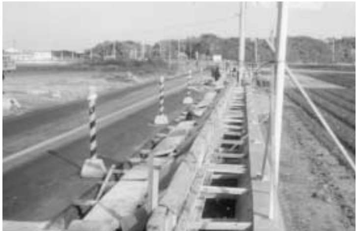
昭和三十九年、新宮湊から塩浜迄の道路改修拡張工事。右側の田圃は現在、スーパーマーケット「ドット」の駐車場になっている。
