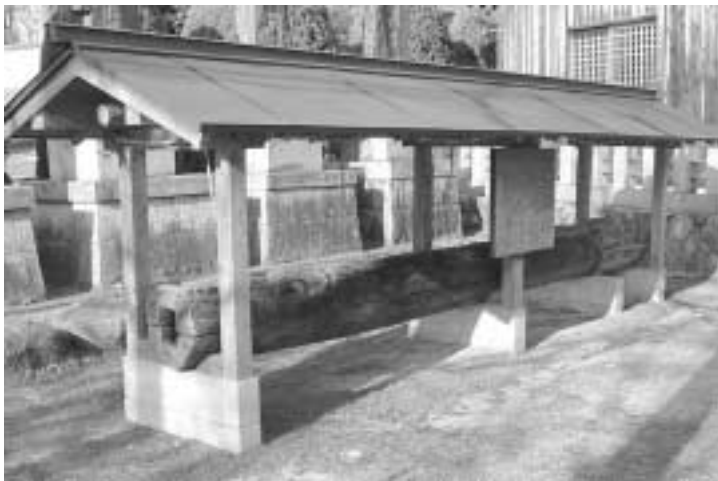
底樋（そこひ＝溜池の水を放流するための管）
