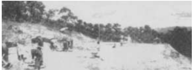
造成中の朝鮮学校用地
