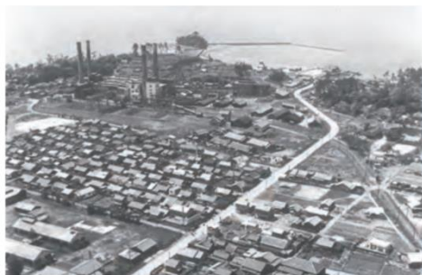
写真右端から発電所に至る引き込み線 (昭和31年当時の写真)
