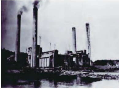
名島火力発電所（昭和5年8月）
